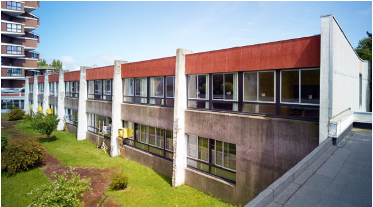
Vue de trois quarts de l'élévation ouest du C.E.S., depuis la toiture du C.E.T.
