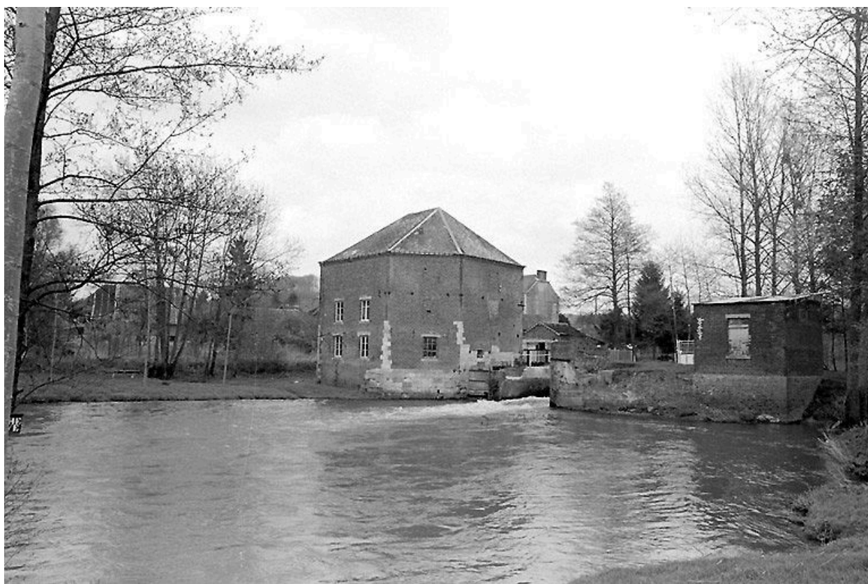
Vue générale du moulin et du barrage depuis le sud-ouest.
