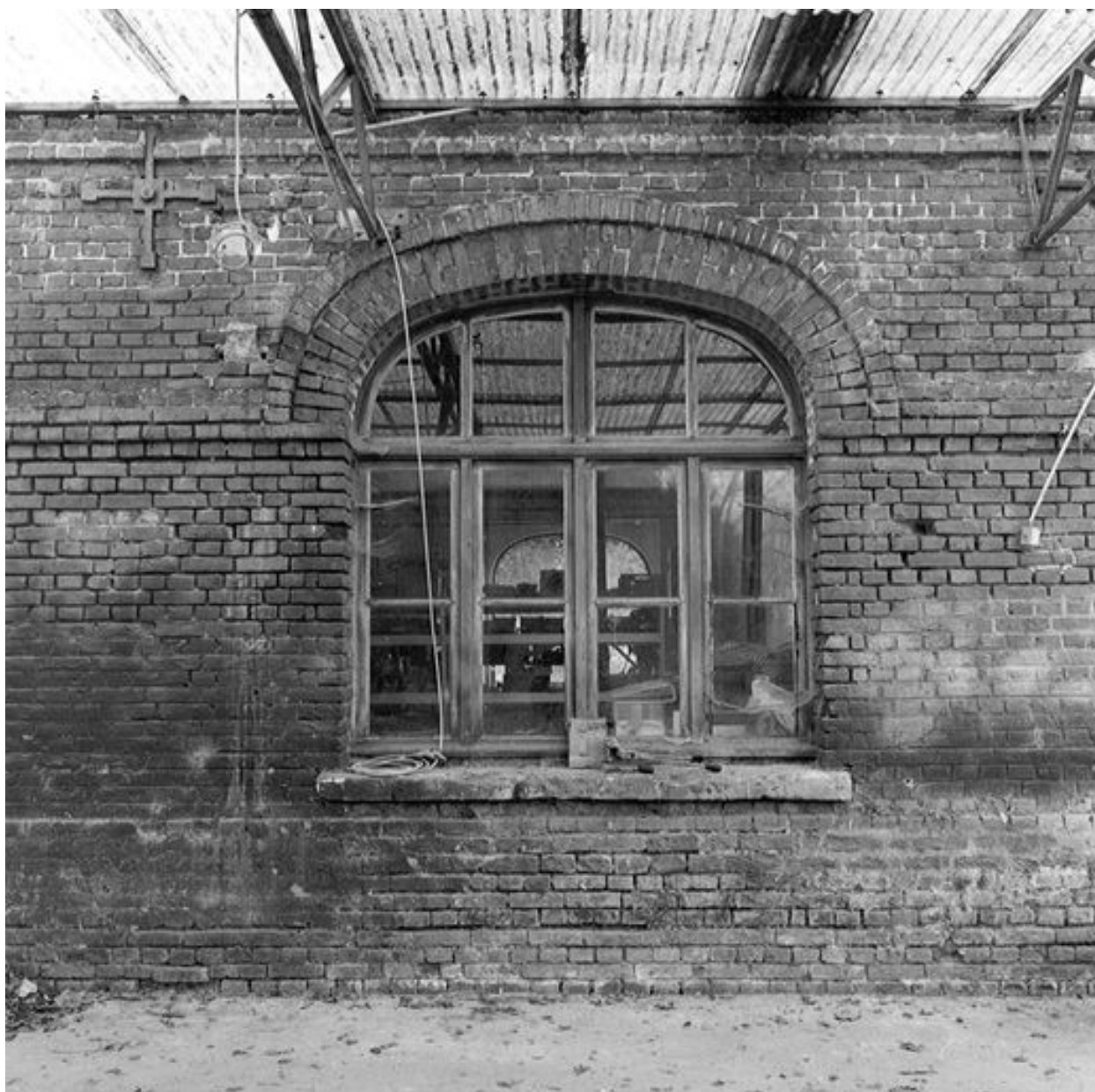
Détail d'une des ouvertures d'origine.
