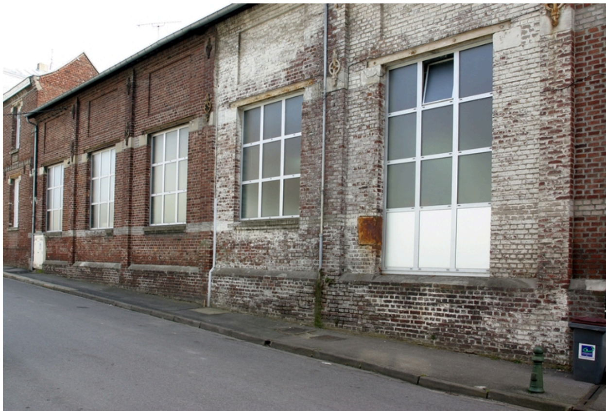
Façade des ateliers, rue des Islots.
