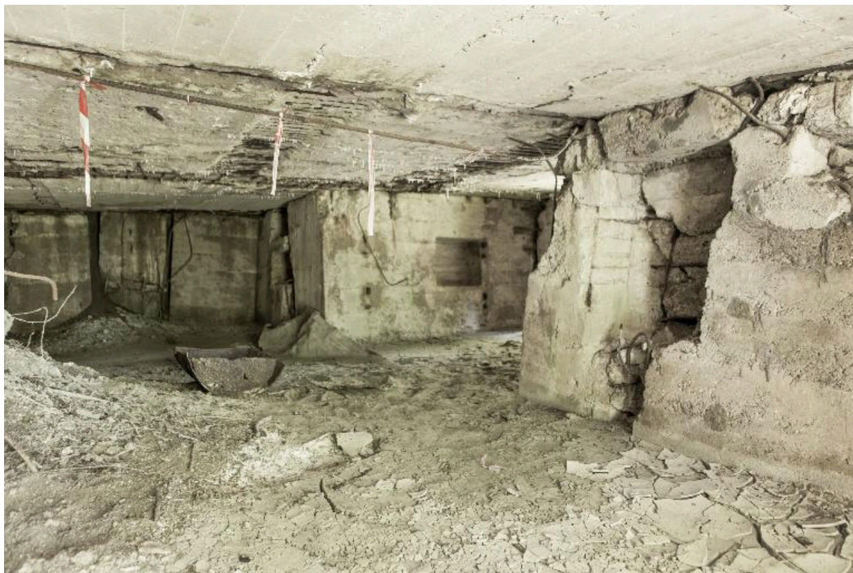
Vue intérieure depuis l'entrée sud
