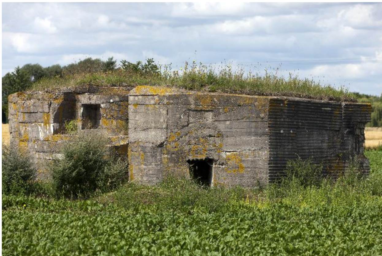
Vue de trois-quarts, vers l'ouest. Entrée est
