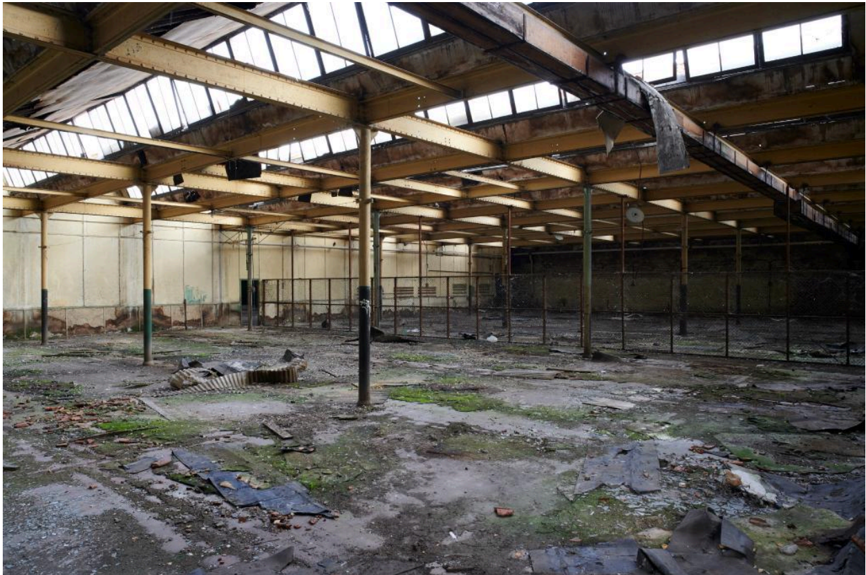
Intérieur de la filature. Vue générale du troisième étage.
