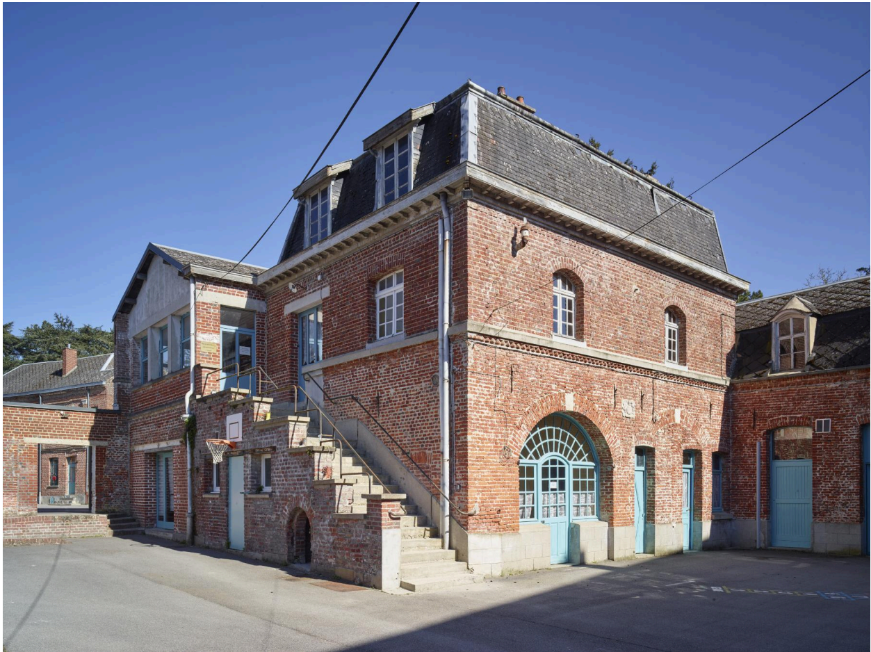
Vue de la façade arrière du pavillon en retour d'équerre de l'aile sur la rue Chevray, depuis la cour de l'école primaire Chevray. Vue orientée sud-ouest/nord-est.
