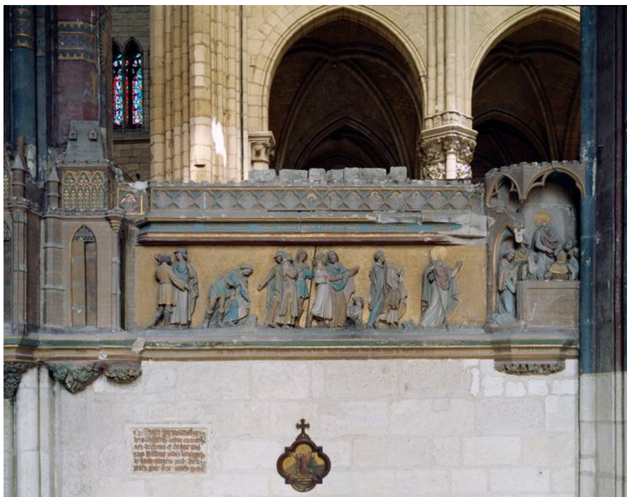
Vue de la première travée sud.
