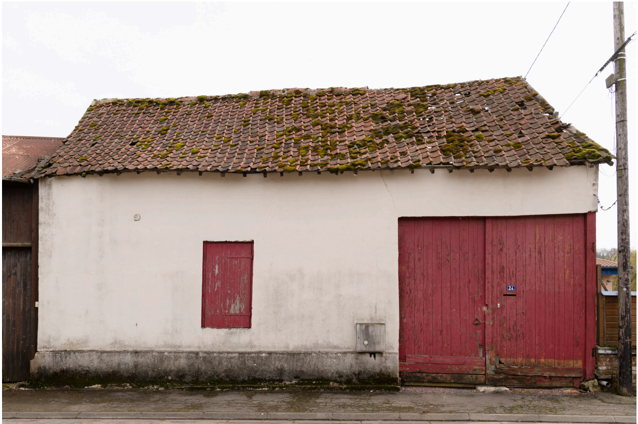
Grange sur rue, n°24 de la rue Poncelet, vue prise depuis le nord.
