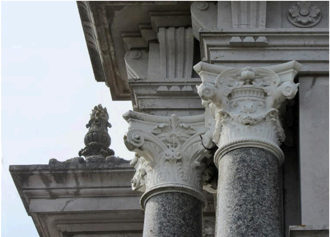
Détail des chapiteaux corinthiens ornés de guirlandes, de rinceaux et de l'initiale S.
