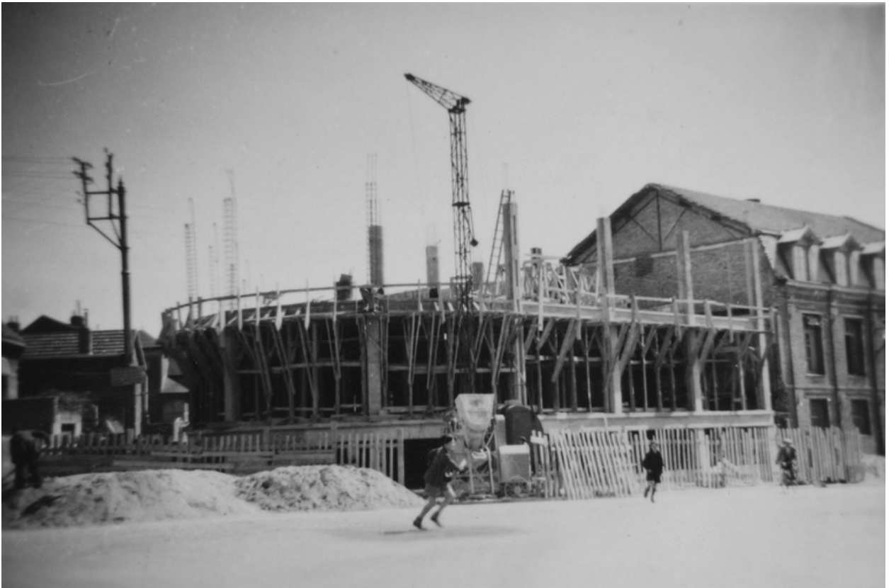
Chantier de construction des ateliers, 1948 (IFA).
