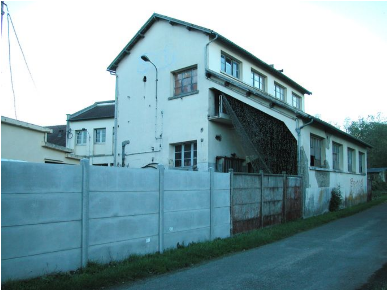
Vue nord-est de l'atelier de fabrication et du quai couvert.
