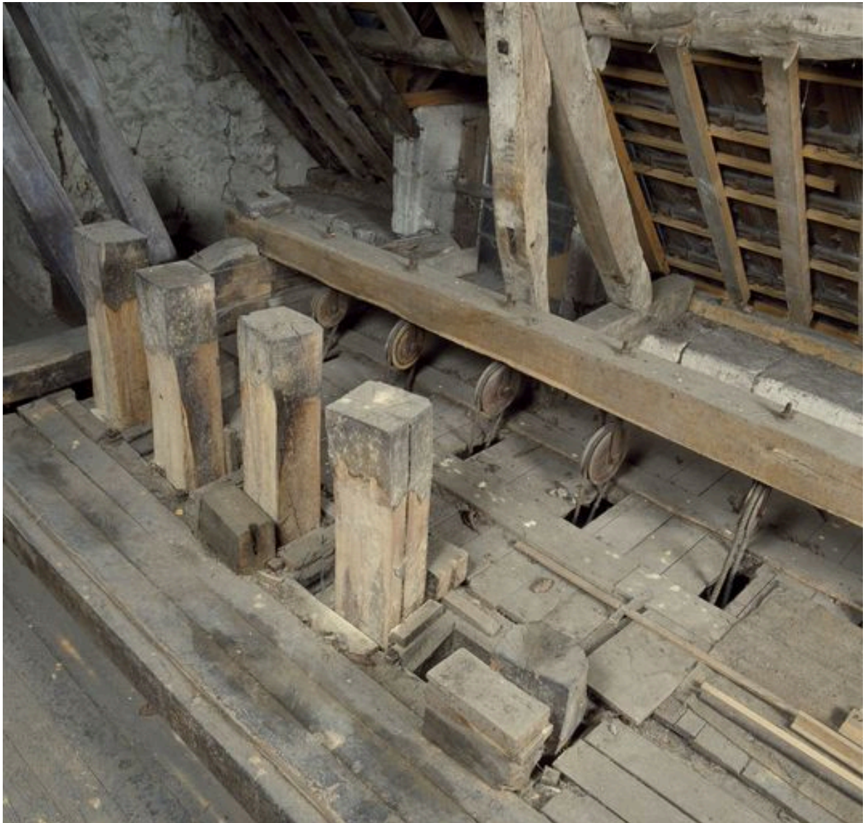
Détail des battoirs (en comble).
