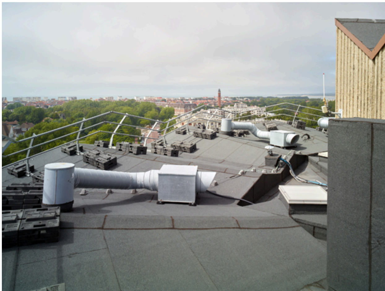
Vue de la toiture de la tour de l'internat.
