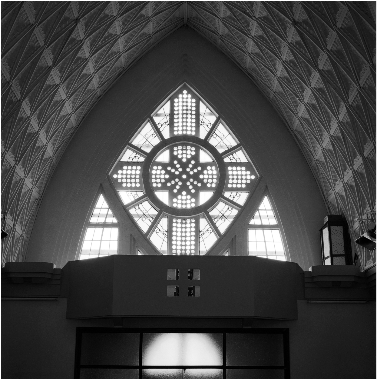
Vue intérieure de la chapelle vers l'entrée, le vitrail de la tribune.
