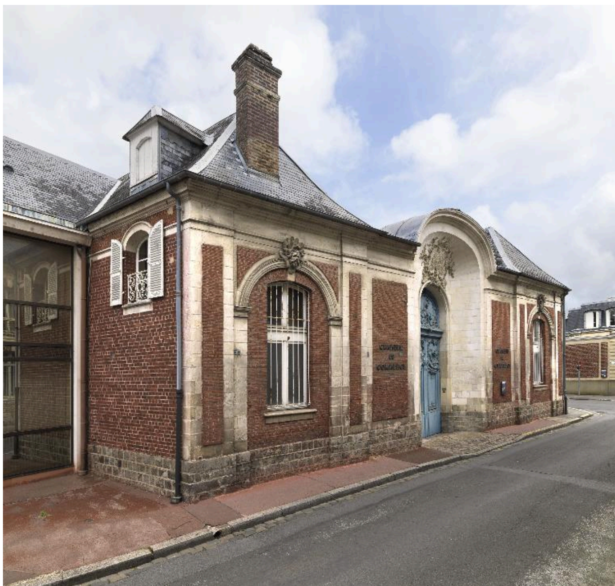
Vue générale depuis la rue Lesueur.
