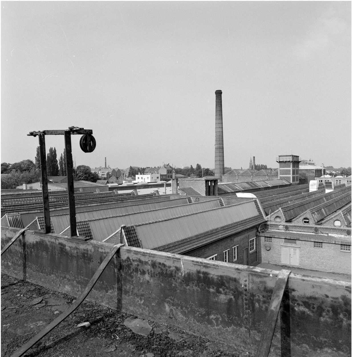
Vue des toits vers le sud-ouest.
