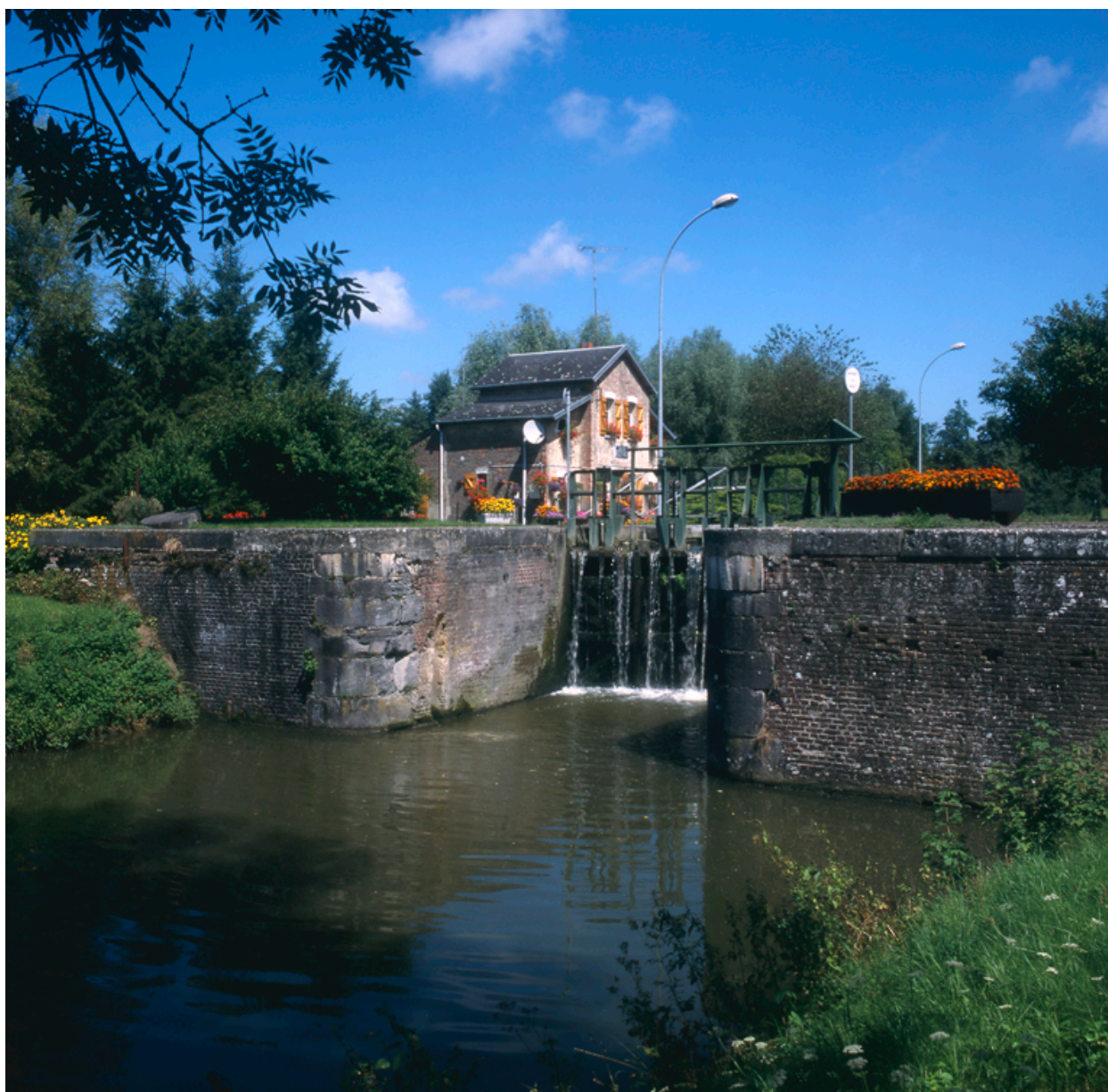
L'écluse de Tupigny, sur le canal de la Sambre à l'Oise.
