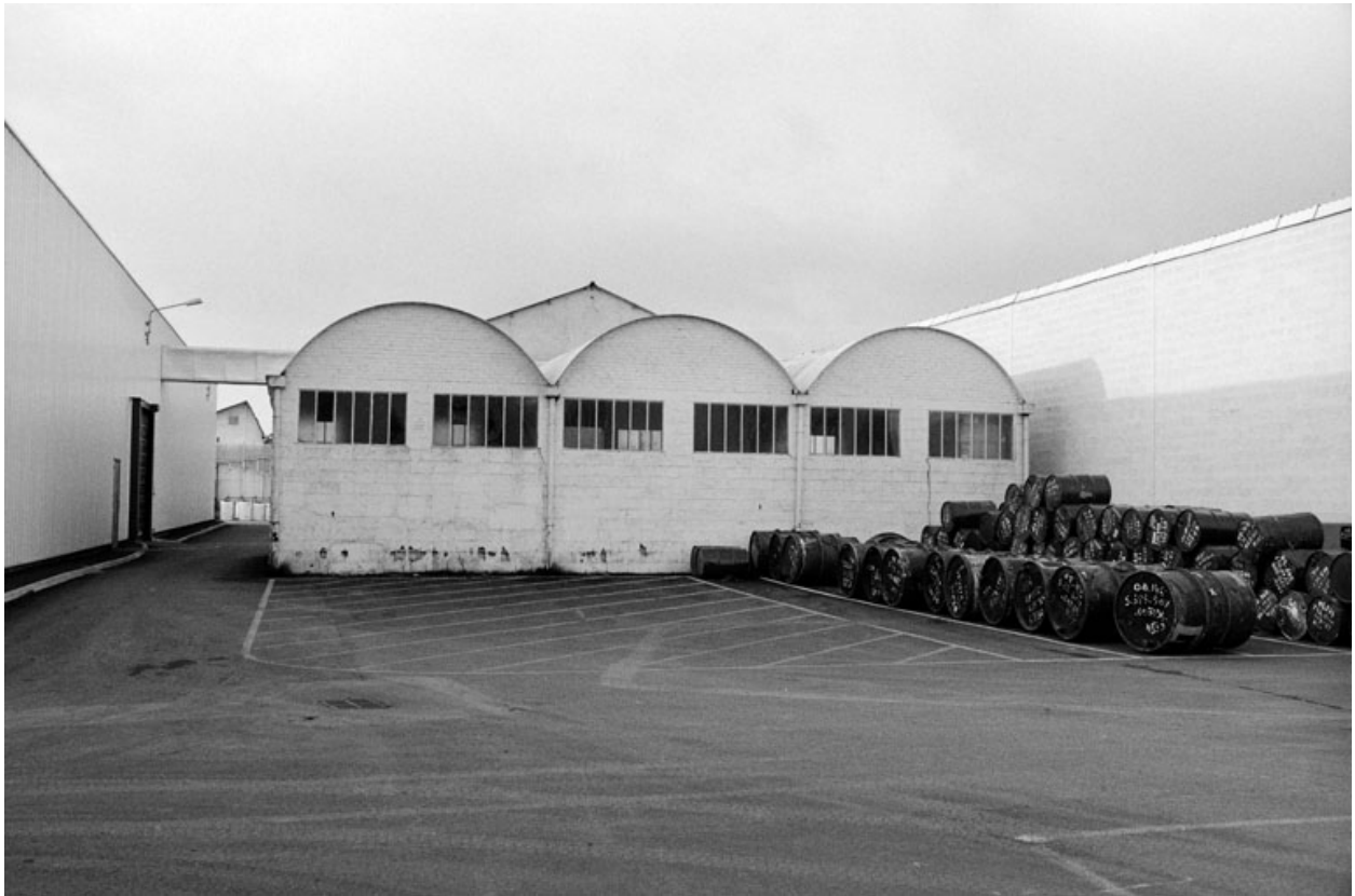
Magasin industriel, flanc est.
