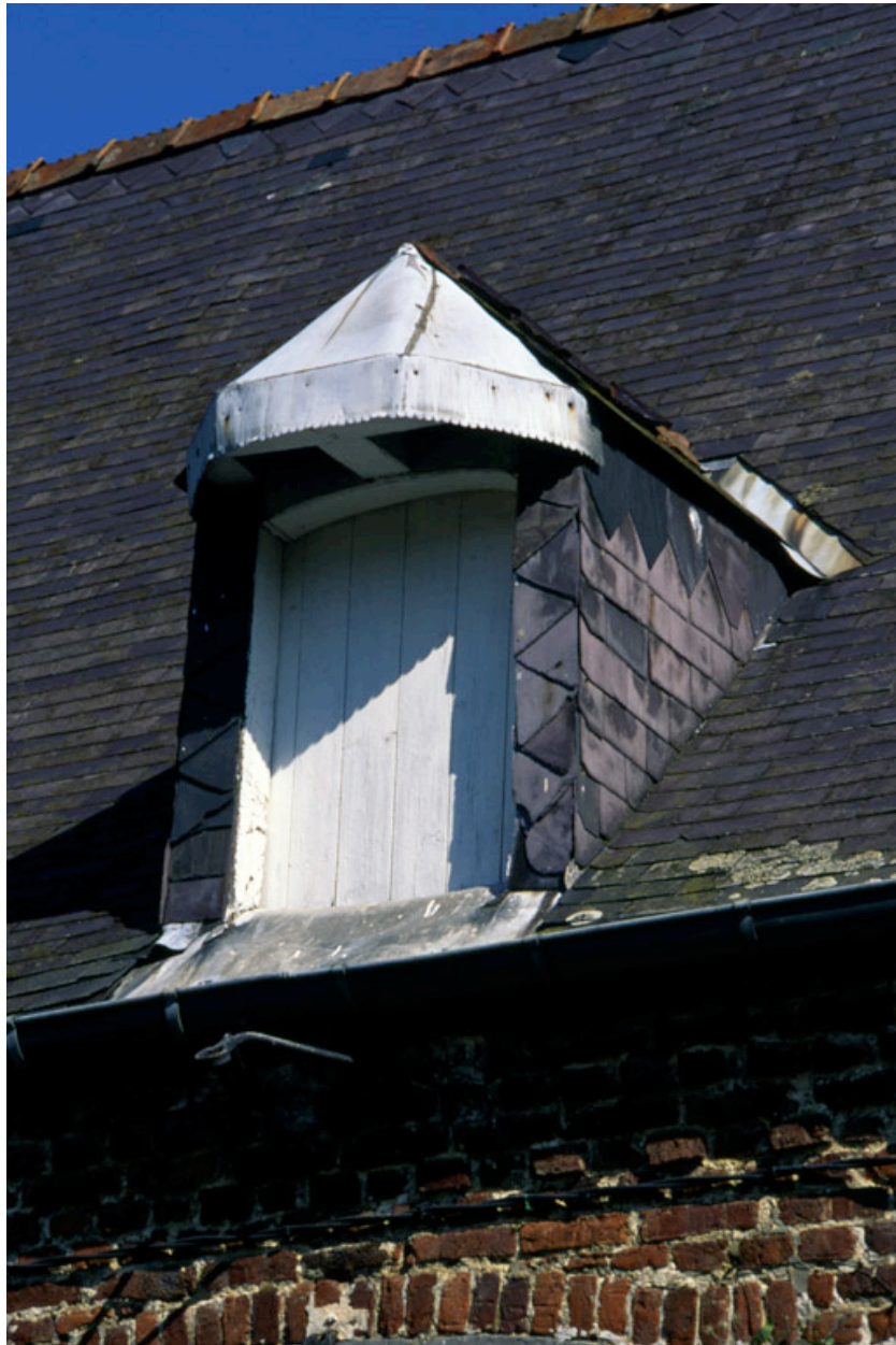
Détail de la lucarne qui surmonte la porte d'entrée.
