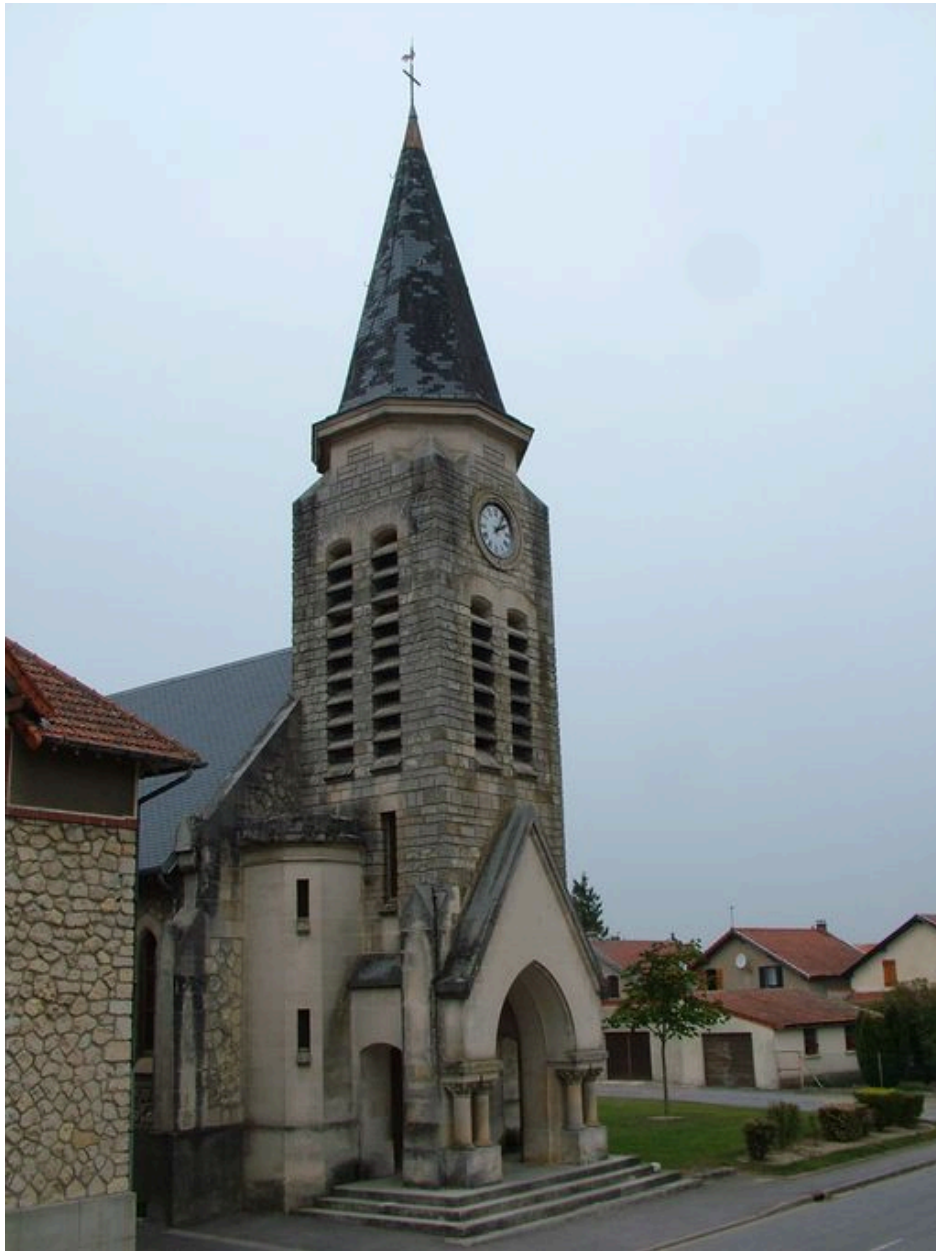
Vue de la façade ouest.
