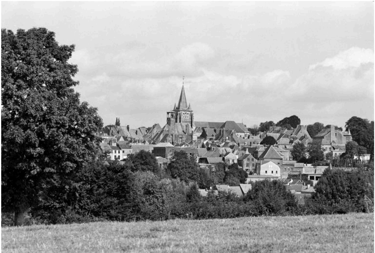
Vue générale, depuis le sud.
