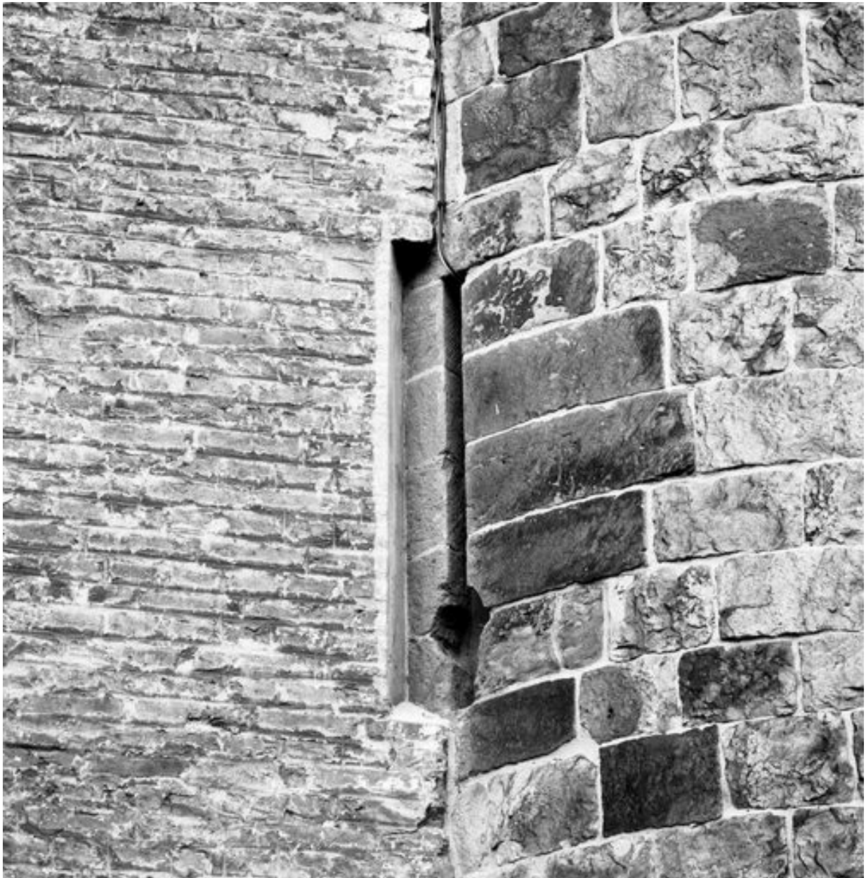
Corps de logis médiéval, façade, liaison avec l'aile n° 35-37 rue de la Bibliothèque, détail : tourelle sud, meurtrière.
