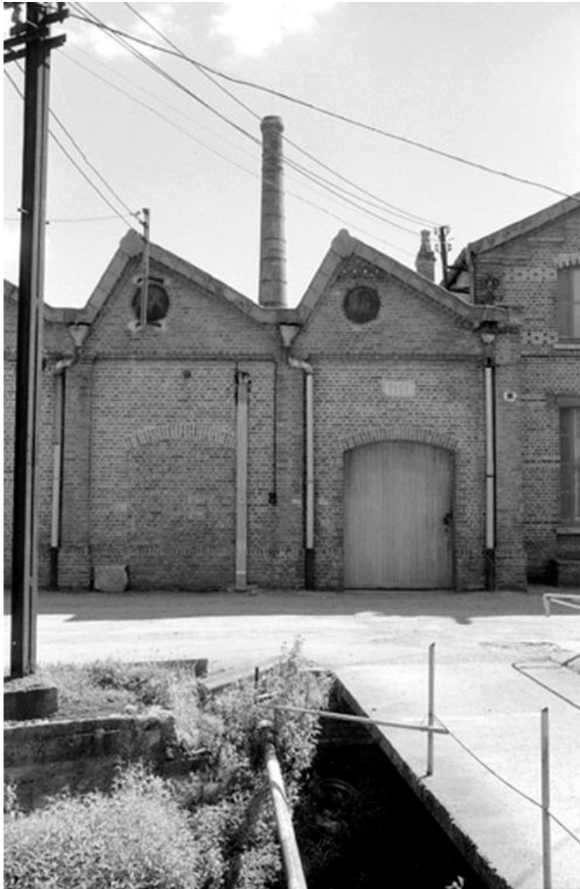
Ateliers de fabrication, élévation nord, détail.
