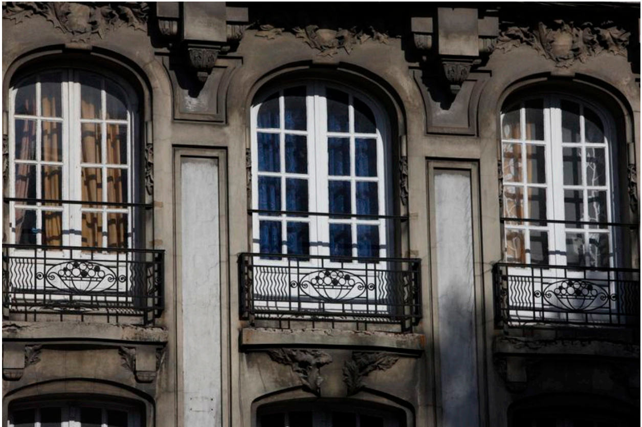
Détail d'un garde-corps au motif de panier stylisé.
