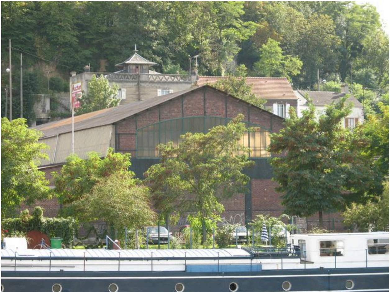
Vue de la halle principale de l'usine.
