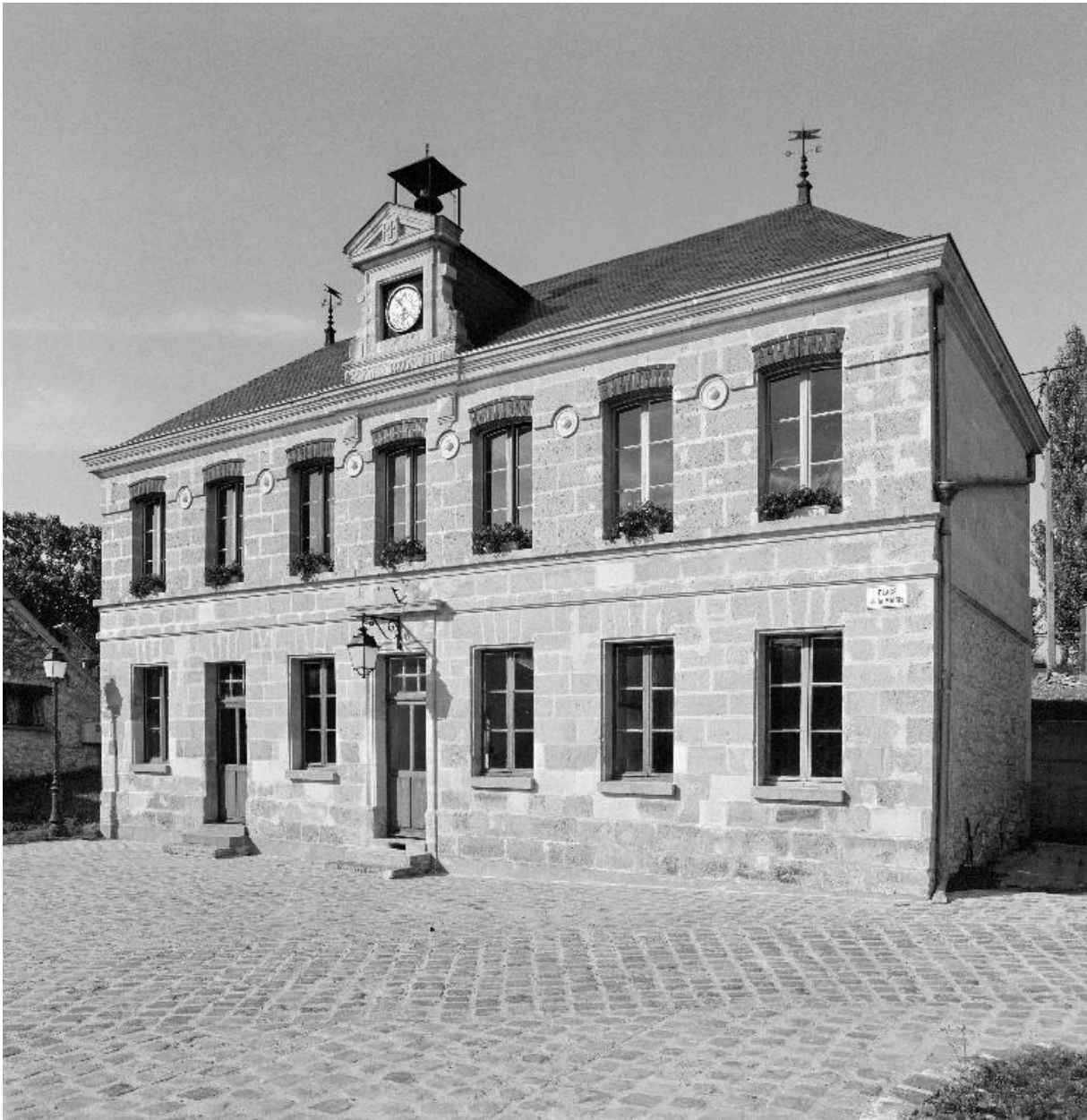
Vue générale sud du bâtiment.
