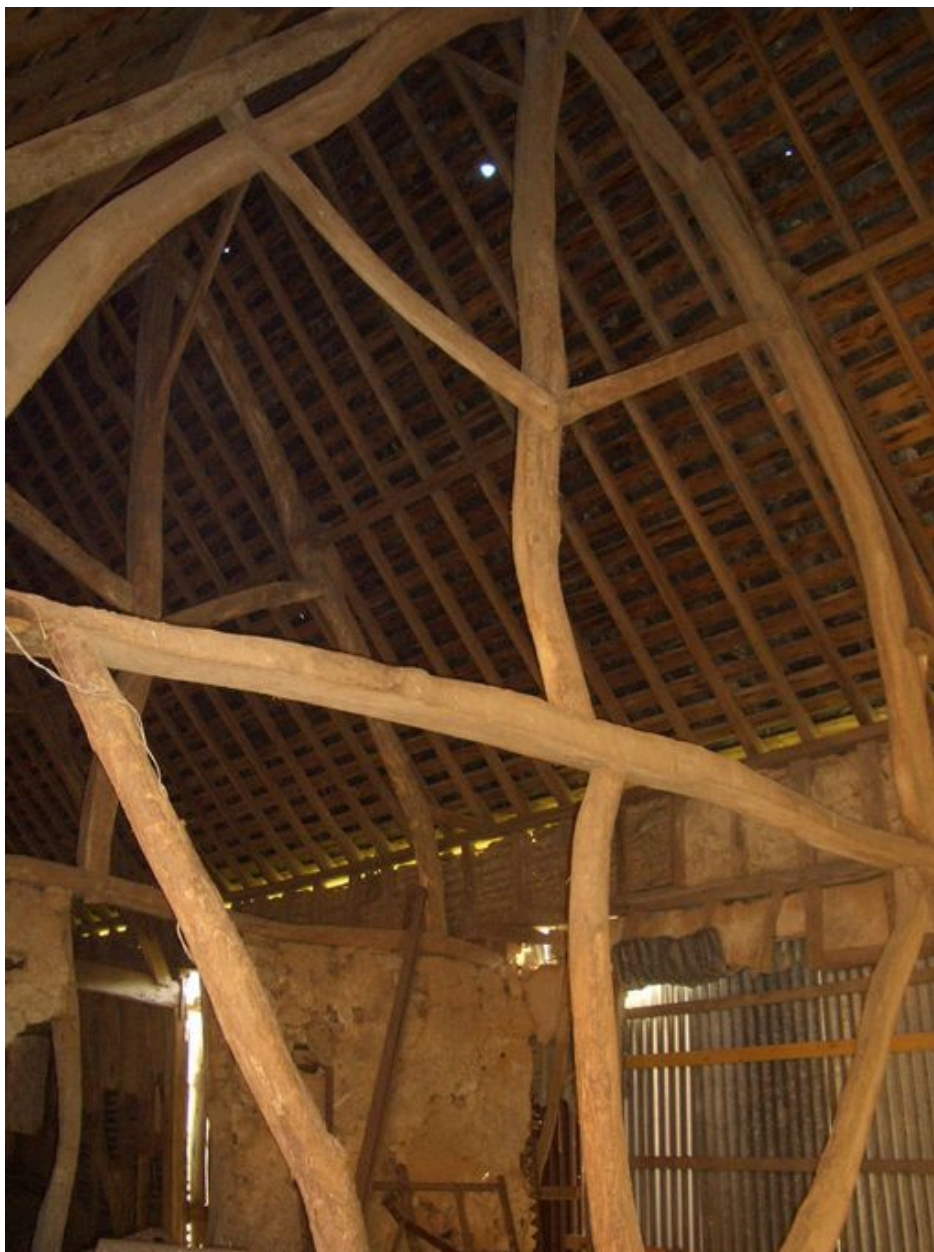
Vue d'une ferme de la grange.
