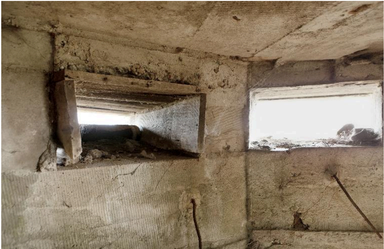
Détail de coffrage dans une des embrasures
