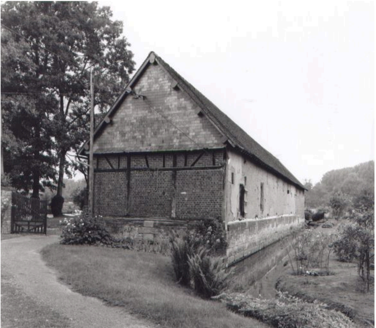
Vue d'ensemble de l'atelier de fabrication, côté nord et pignon est.
