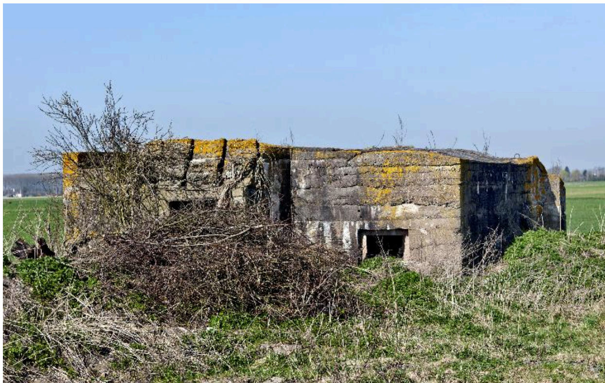
vue de trois-quarts vers le nord-ouest
