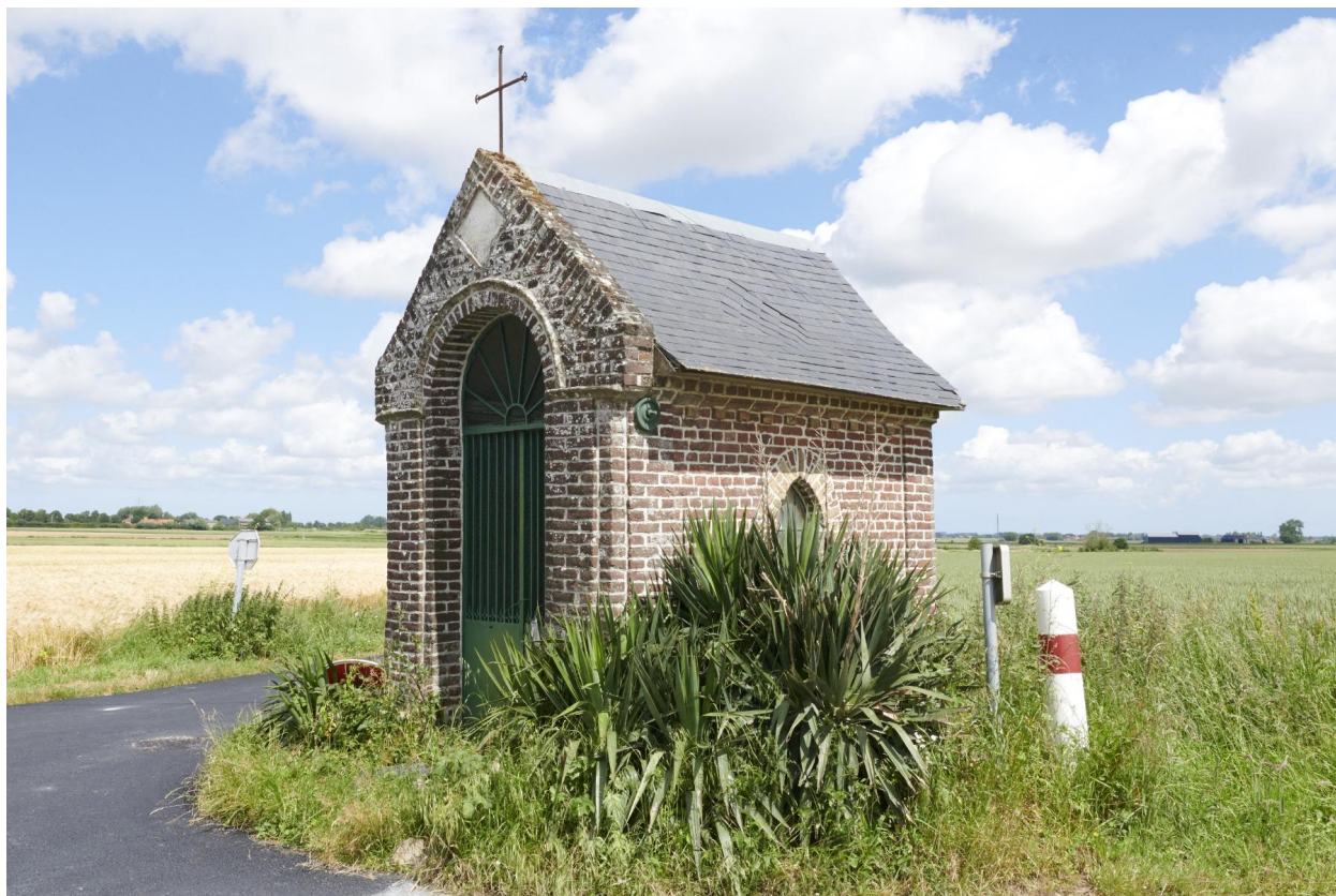
Vue façade et côté sud-est.
