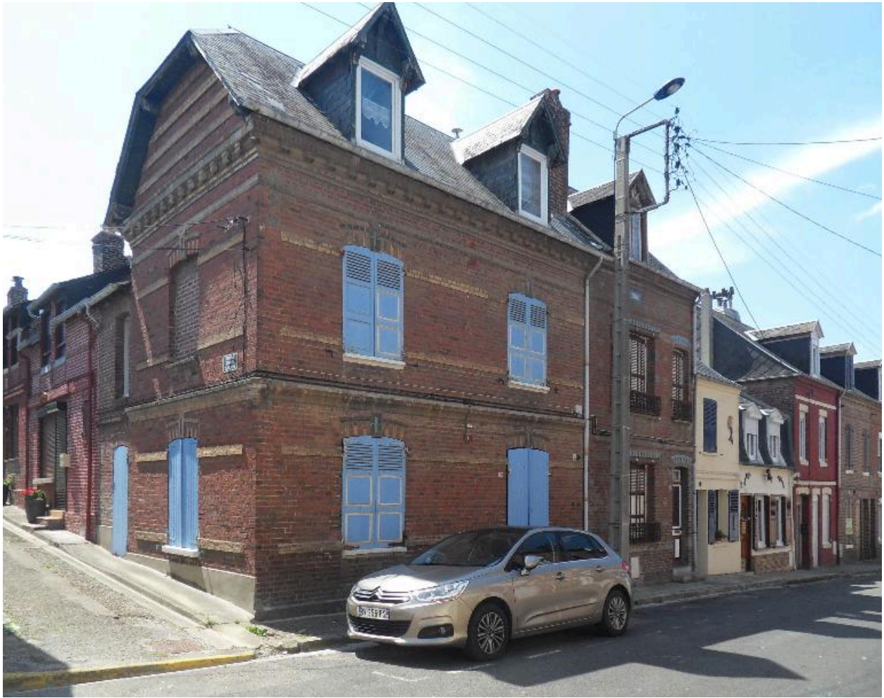
Logement de contremaître.
