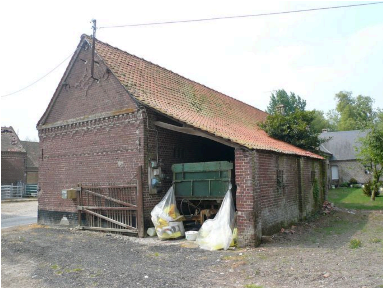
Vue postérieure des écuries avec charretterie.
