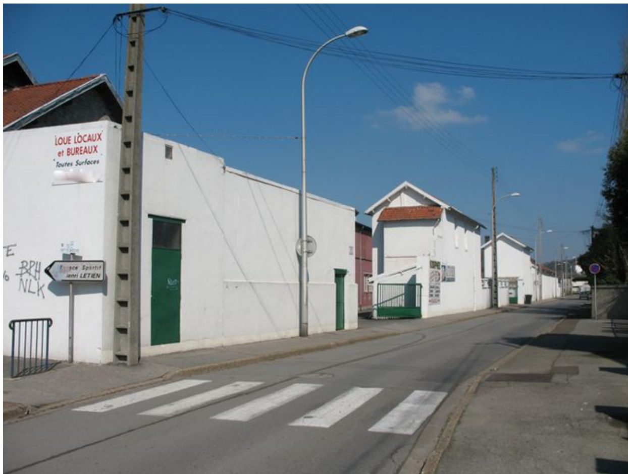
Les bâtiments de la Société industrielle Creilloise depuis la rue Charles-Somasco.
