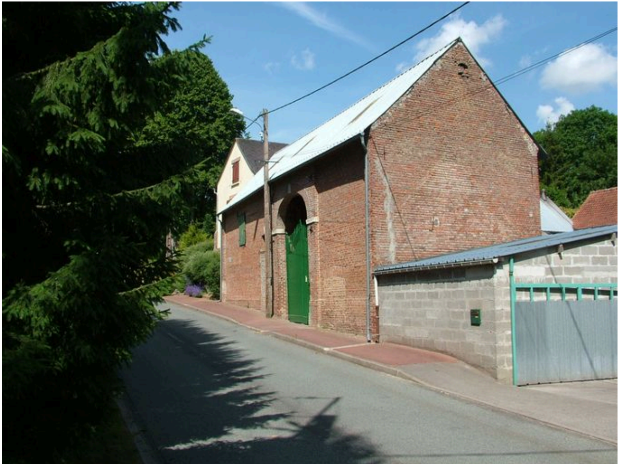
Vue générale depuis la rue, en aval.
