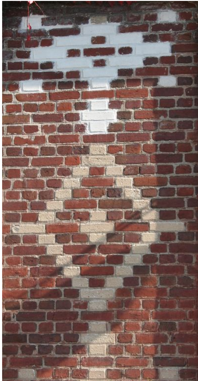
Détail de la mise en oeuvre des briques.
