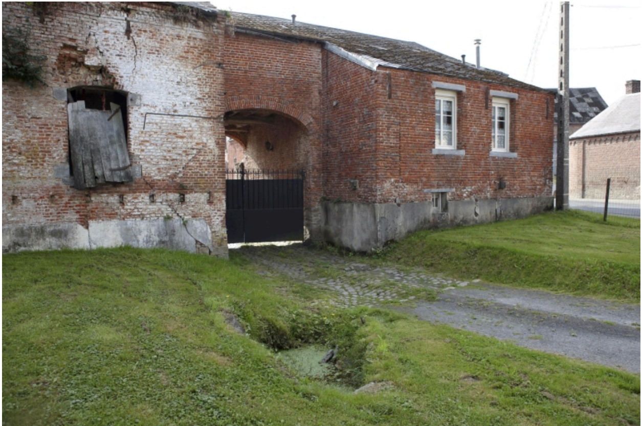
Élévation sur rue d'une partie de l'ancienne salle des cuves, du porche et du logis.
