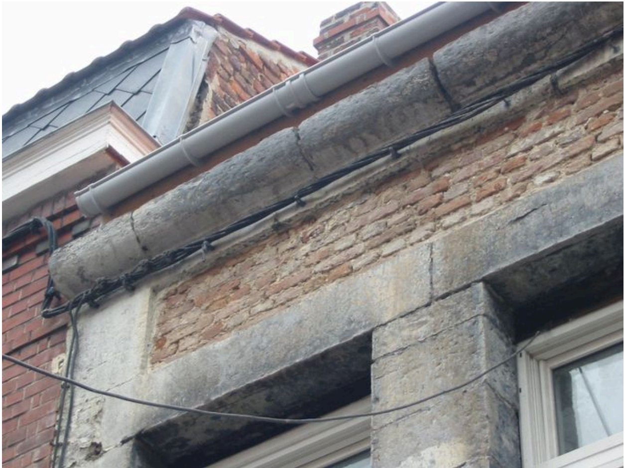
Façade, détail : corniche en quart de rond.
