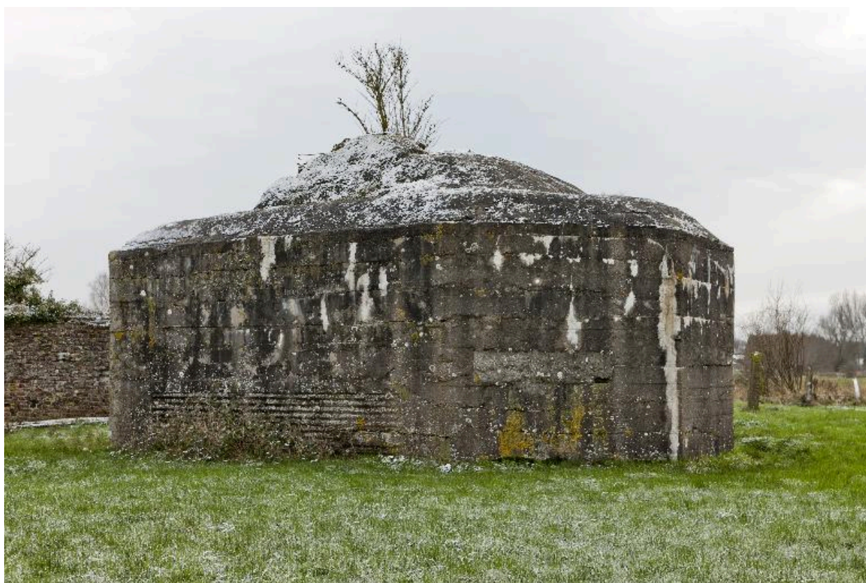
Casemate nord, vers le sud
