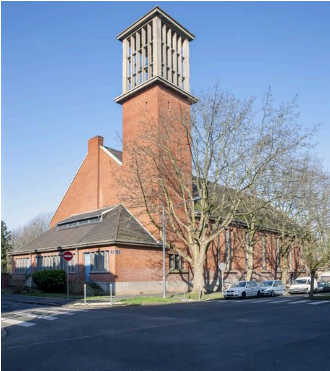
Élévation postérieure et flanc gauche.
