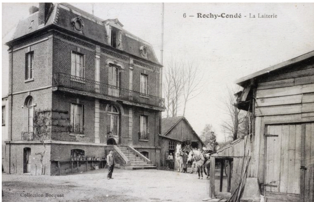
Vue d'ensemble du logement patronal de la laiterie avant destruction (carte postale, coll. part.)
