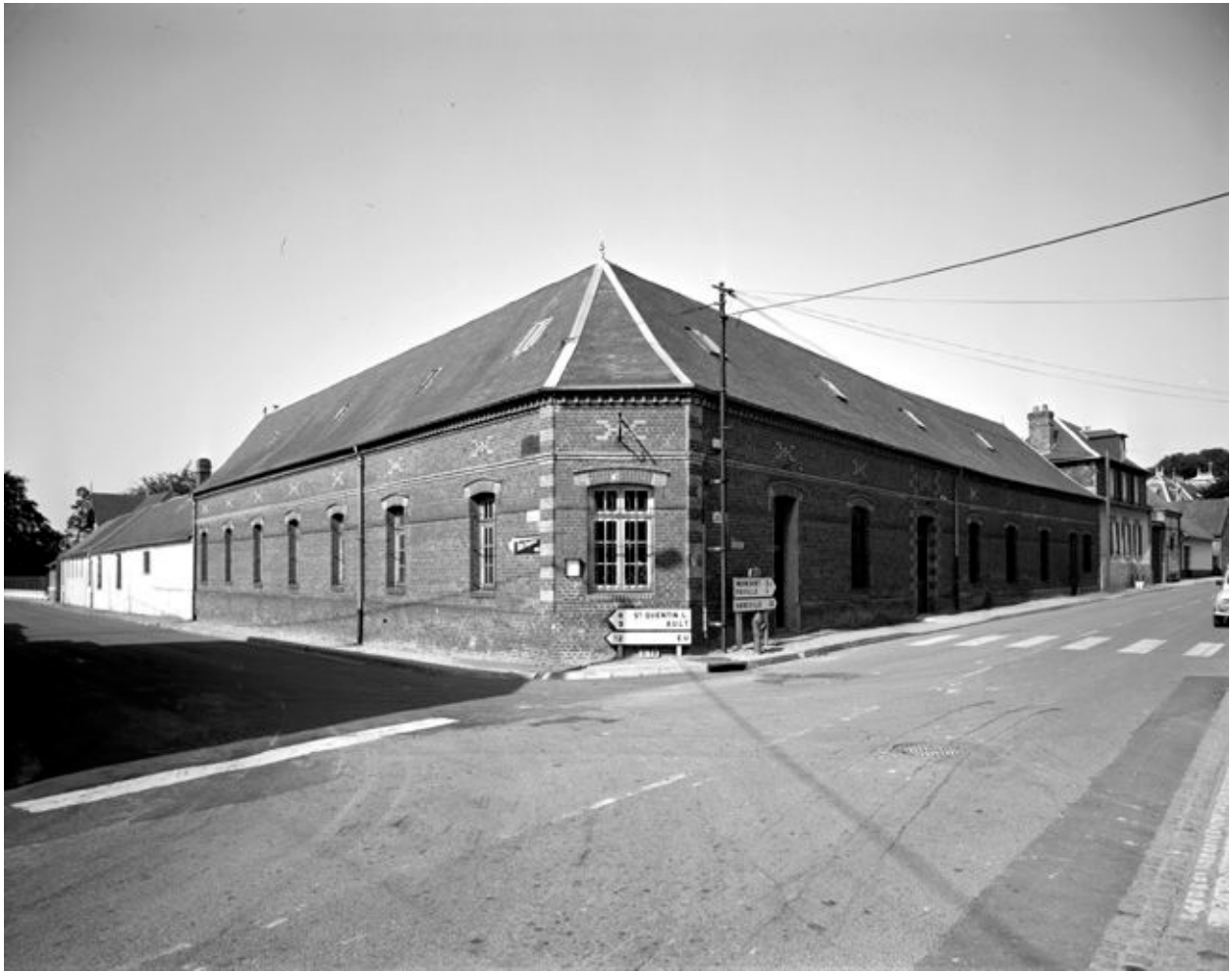
Vue depuis le carrefour de la rue Albert-Camus, en 1988 : les ateliers.
