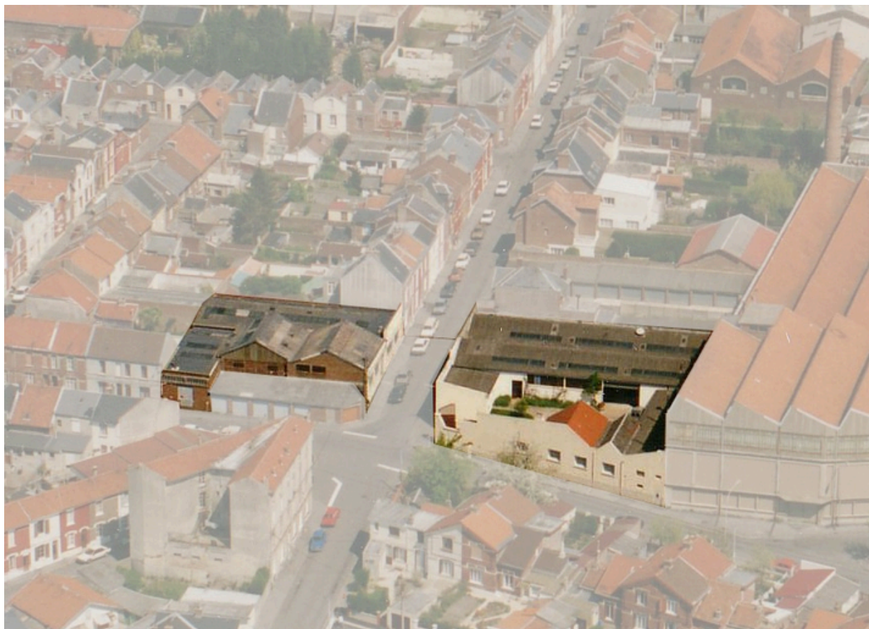
Vue aérienne vers 1989 (BM Saint-Quentin).
