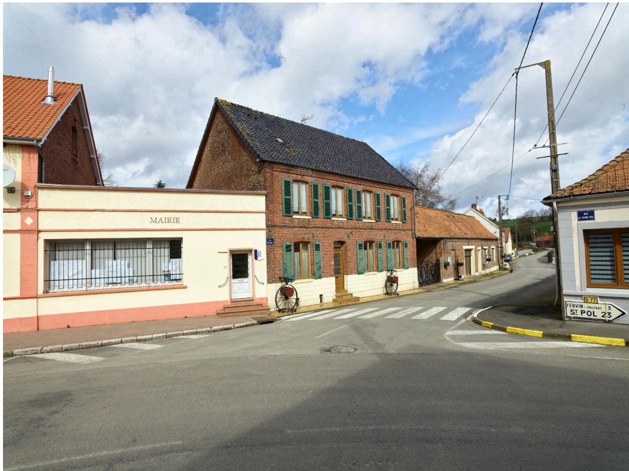
Vue générale de la ferme de puis le sud.
