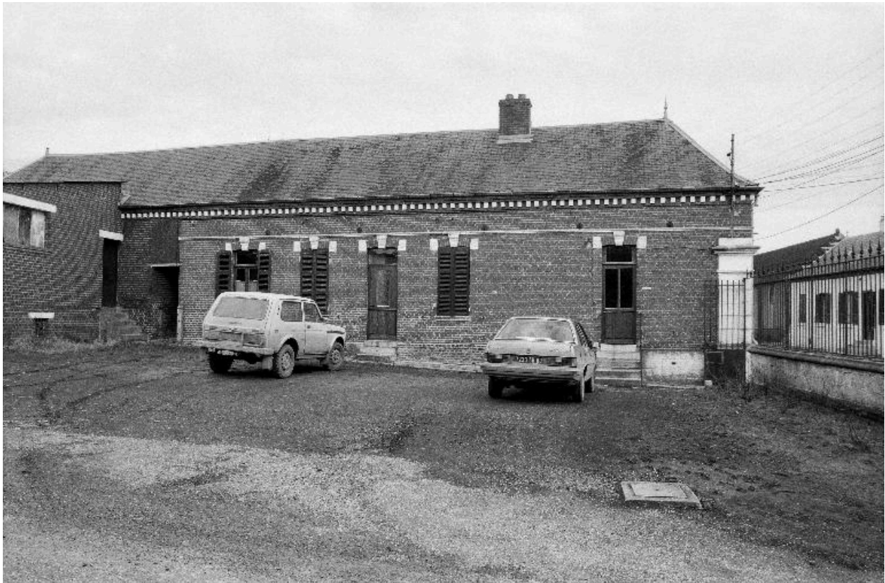
Bureau, conciergerie. Élévation antérieure.
