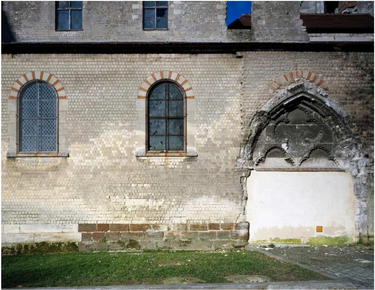
Vue du flanc sud.
