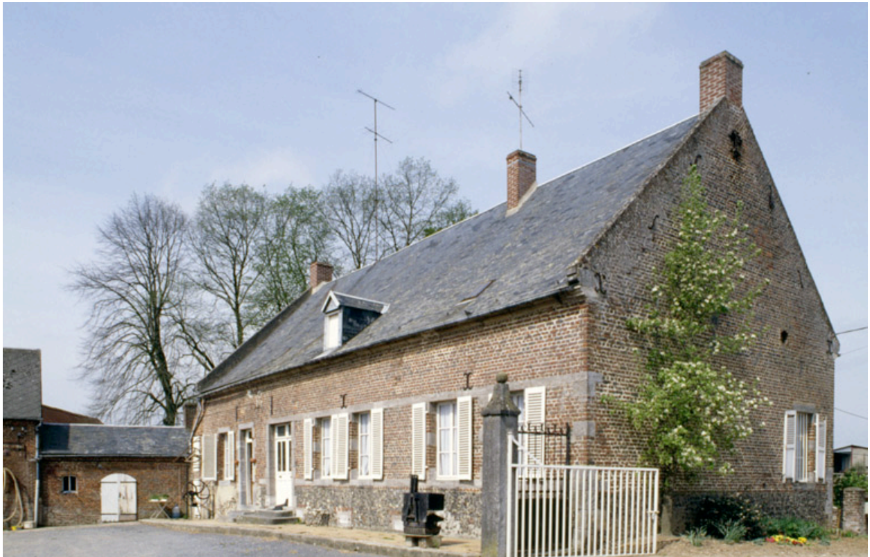
Dorengt, ferme (repérée), 14 ruelle Champagne : logis daté de 1837 et parties agricoles.
