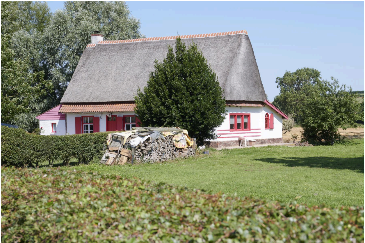
Façade sud et pignon est.
